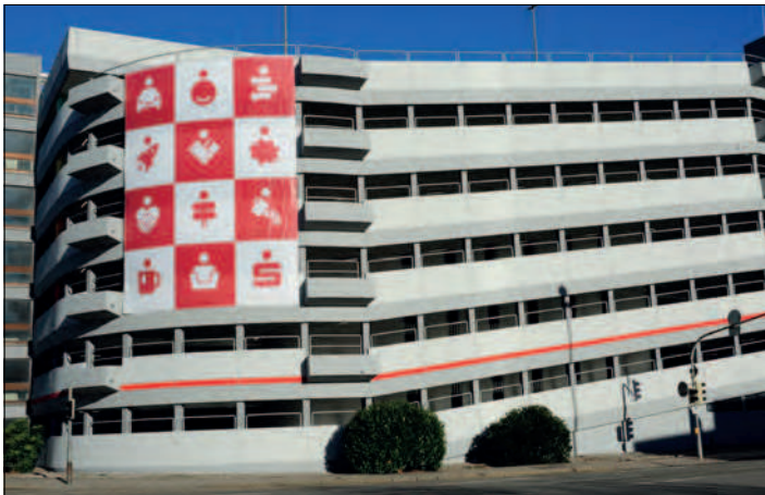
Sparkassen-parking-garage (Sparkassen-Parkhaus, Luisenstraße 4, 75172 Pforzheim)
